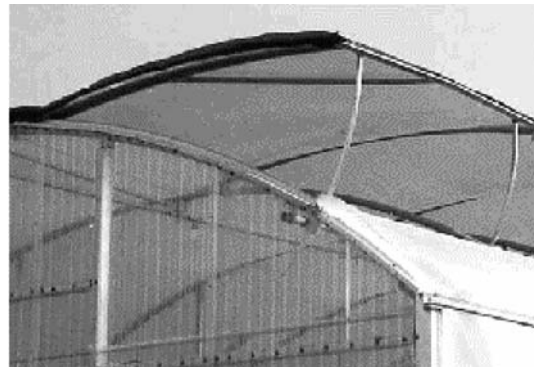
圖 2c. 中段式連續天窗 (Mid-Wing)
