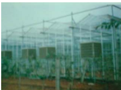
圖 14a. 溫室外安裝側吹式單元機
