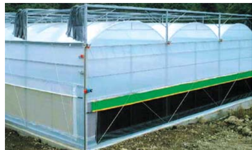
圖 1b. 外遮蔭(針織銀網)實施例
