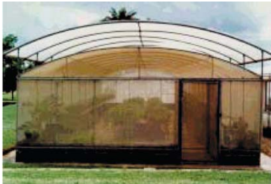
圖 3c. 抗風與防蟲性的改良 (上層塑膠布，下層與四週為防蟲網)
