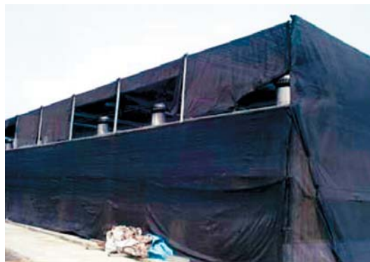
圖 3e. 安裝免電力排風器於屋頂 (豌豆芽栽培溫室)
