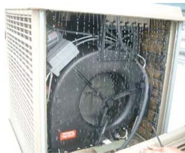
圖 13b. 下吹式正壓式蒸發冷卻單元機
