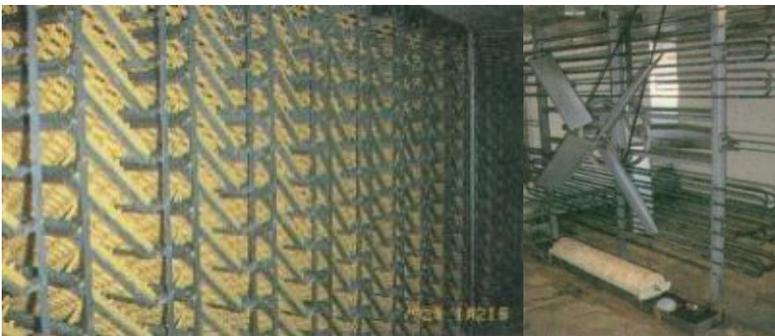
圖 3. 孵蛋室蛋架與溫度濕度調控設備
