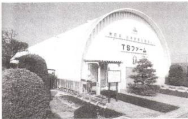
照片 5-15 TS 式植物工厂外貌
