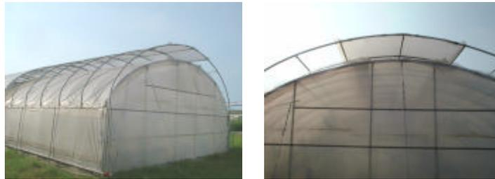
圖 6. 同太子樓式通風的雙層鋸管溫室
