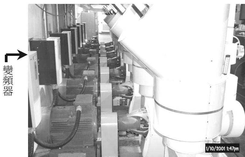
圖七、水泵附變頻器安裝圖
